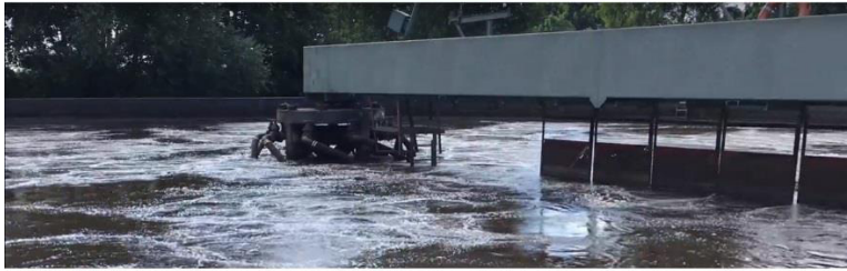
Tauchmotor-Rührwerk 3M im Klärwerk Badbergen Submersible Motor Agitator 3 M in WWTP
