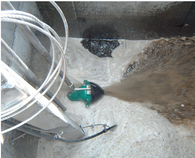
Rührdüse in Betrieb | Agitating nozzle in operation
