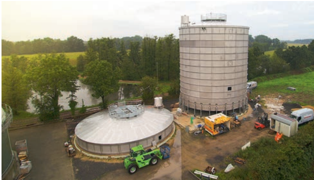
Anheben des Behälters mit Hubstützen Lifting of the tanks with lifting supports
