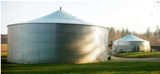
Wellstahlbehälter und aufgestockter Betonbehälter mit Wellstahlbehälter Corrugated steel tank and heightened concrete tank with corrugated steel tank
