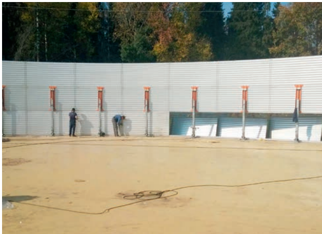
Montage mit Hebevorrüchtung Assembly with lifting gear
