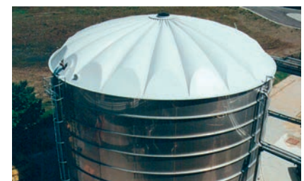
Ausführung Rippenkuppeldach Ribbed dome roof design
