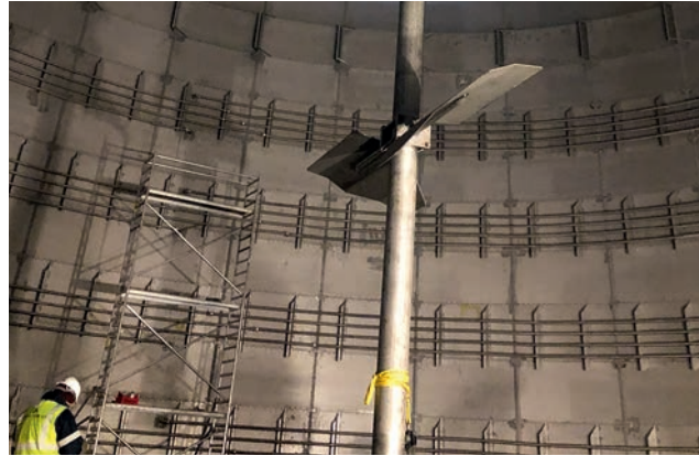
Montage Zentralrührwerk Assembly of central stirring system
