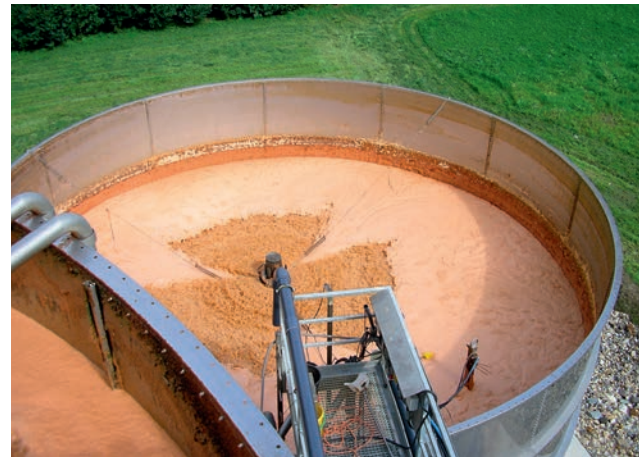
Abwasserbehälter Waste water tank
