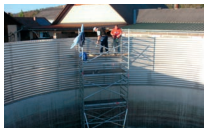
2. Ring auf Betonbehälter 2. Ring on concrete tank
