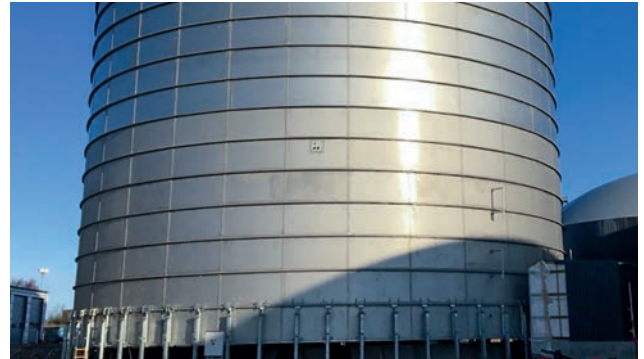
Montage durch Unterstockung Assembly by adding depth
