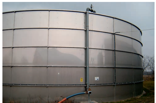
Saug- und Befüllstation über Behälterrand Suction and filling station above tank edge
