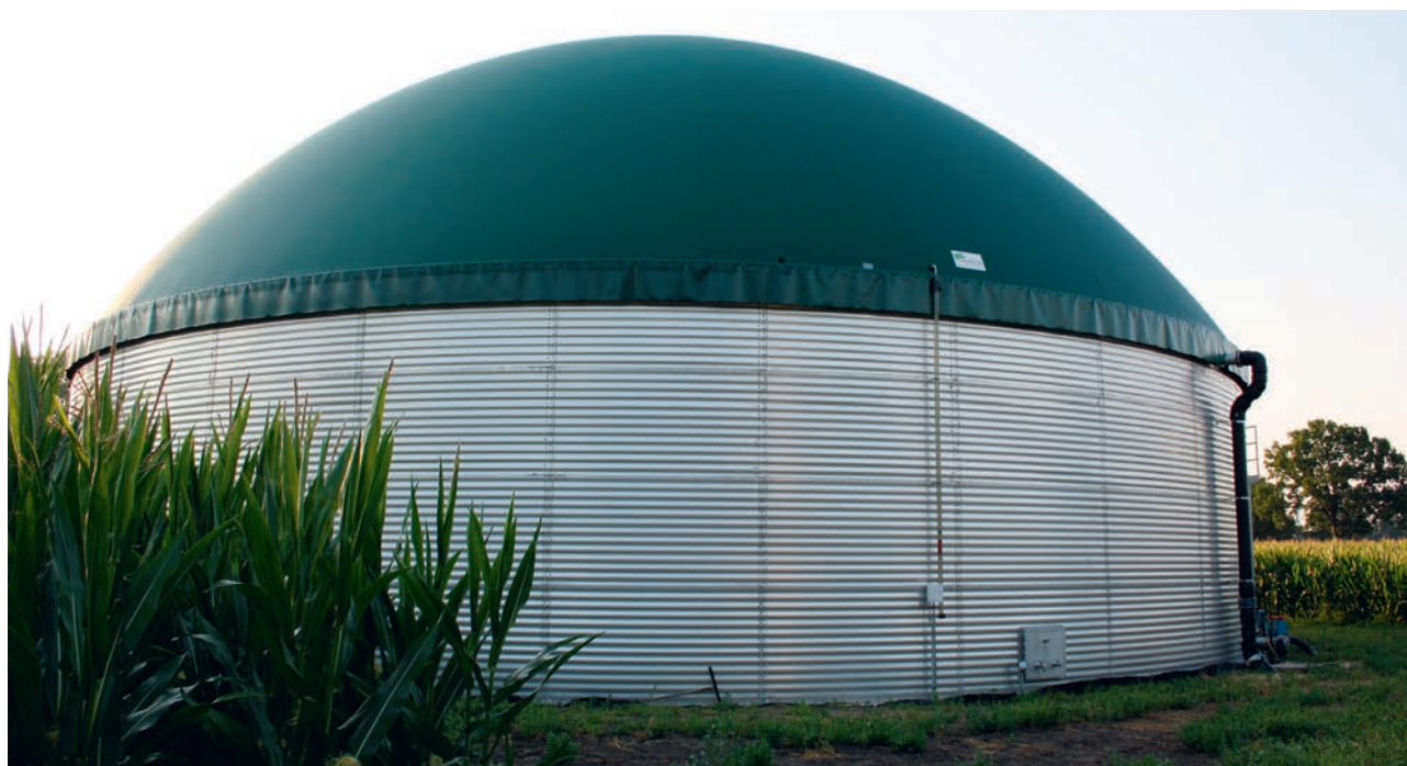
V4A Biogasbehälter mit gasdichtem Doppelmembrandach | Digestate storage in stainless steel 1.4571 with gas-tight double membrane roof
