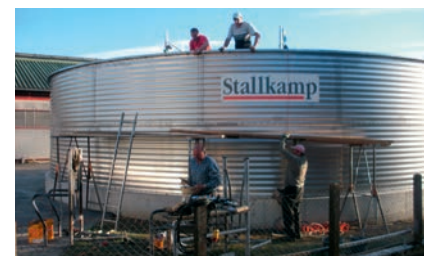
Aufgestockter Betonbehälter Heightened concrete tanks
