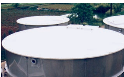
Ausführung Flachdach Flat roof design
