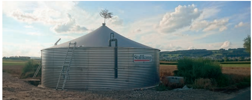
Behälteransicht außen mit Membrandach | Tank view outside with membrane roof
