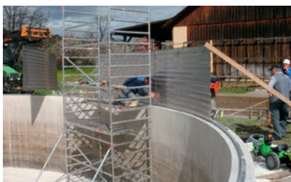
Aufstockung eines Behälters Adding height to a tank
