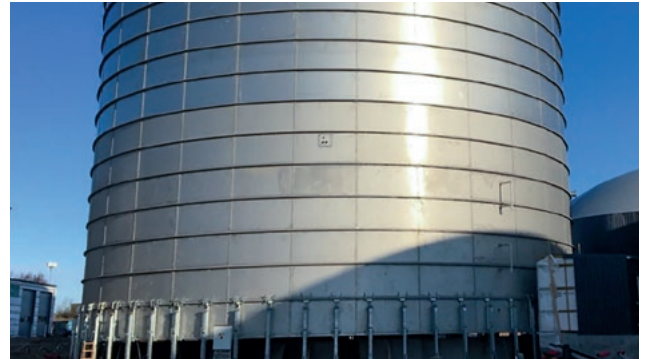
Montage durch Unterstockung Assembly by adding depth
