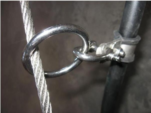
**Bild 3: Kabelschelle mit Schäkel und Ring**
