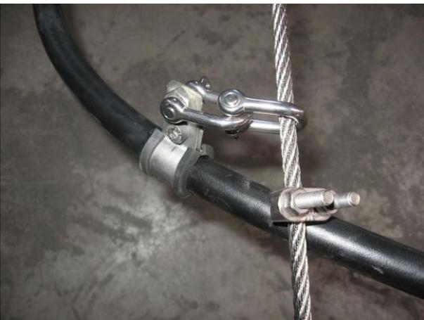
**Bild 4: Seilklemme und 1. Kabelschelle**
