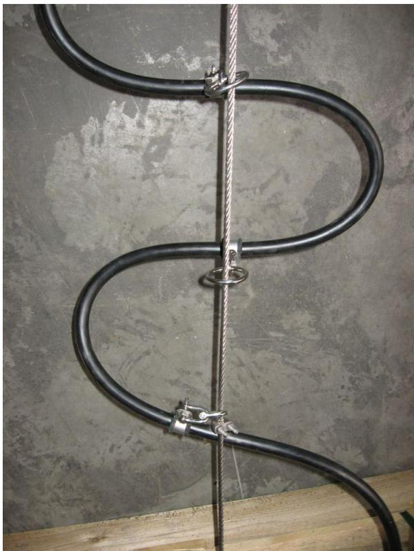
**Bild 7: Kabelführung am Drahtseil**
