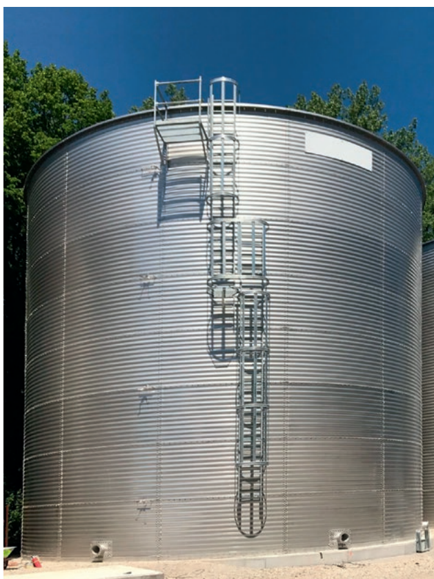
Хранилище бентонитовой суспензии 1304 м 3 в Швейцарии Zbiornik zawiesiny bentonitowej 1304 m 3 , Szwajcaria
