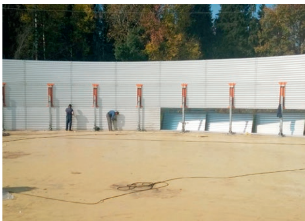
Монтаж с подъёмным устройством Montaż za pomocą podnośników
