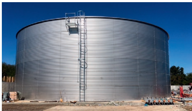
Один из 17 резервуаров для жидкого навоза 4230 м 3 в Болгарии Jeden z 17 zbiorników na gnojowicę 4230 m 3 , Bułgaria
