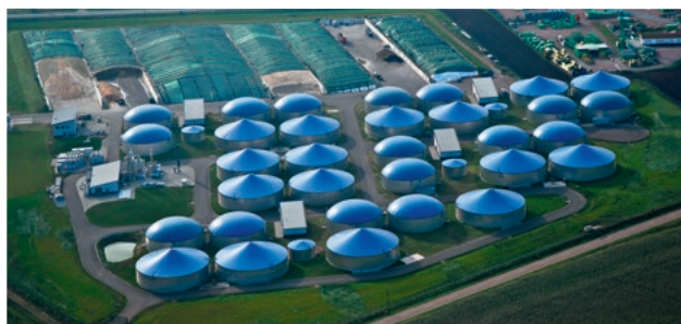
Ферментёры, дображиватели и склады остатков брожения биогазовой установки Komory fermentacyjne, zbiornik fermentacji i zbiorniki masy pofermentacyjnej w biogazowni
