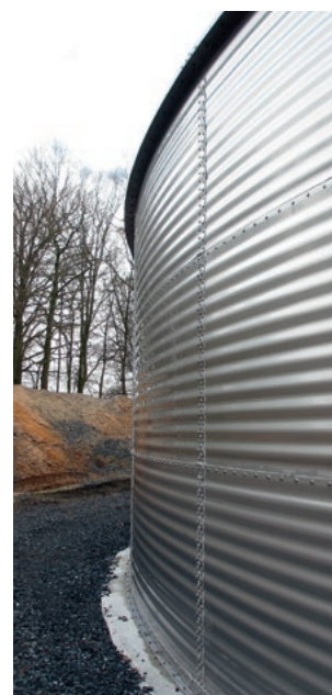
Стенка резервуара Widok z boku
