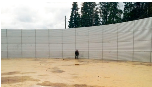
Самый большой в мире резервуар из волнистой нержавеющей стали 8559 м 3 возле Кирова (Россия) | Największy na świecie zbiornik z blachy falistej o pojemności 8559 m 3 ze stali szlachetnej, pod Kirowem (Rosja)
