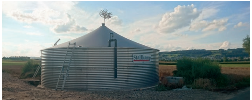
Вид резервуара снаружи с мембранной крышей Widok zewnętrzny zbiornika z dachem namiotowym
