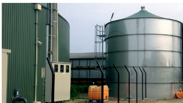
Питающий и накопительный резервуары в Японии Zbiorniki buforowe, Japonia
