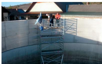
2-е кольцо на бетонном резервуаре 2. pierścień na zbiorniku betonowym
