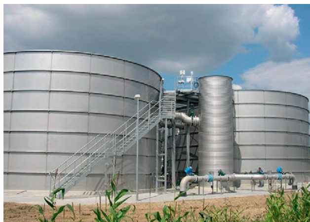
Резервуар из гладкой листовой стали 1664 м 3 и резервуар из волнистой стали 51 м 3 в бумажном производстве | Zbiornik z blachy gładkiej 1664 m 3 oraz zbiornik z blachy falistej 51 m 3 w przemyśle papierniczym
