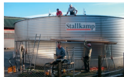
Надстроенный бетонный резервуар Rozbudowany w górę zbiornik betonowy
