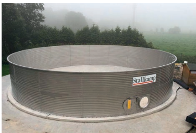
Хранилище осадка сточных вод из волнистой стали 572 м 3 Zbiornik osadów ściekowych 572 m 3 z blachy stalowej falistej
