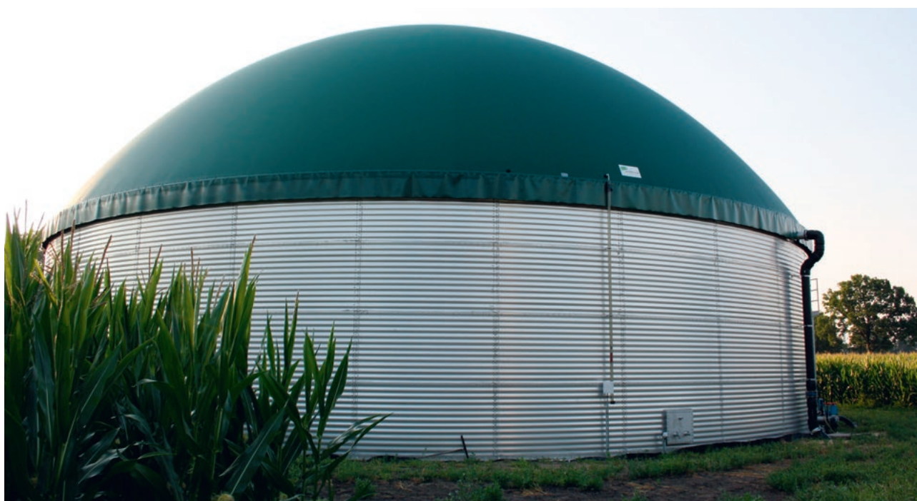
Биогазовый резервуар из стали V4A с газонепроницаемой двойной мембраной | Zbiornik biogazu V4A z gazoszczelnym dachem z membrany podwójnej
