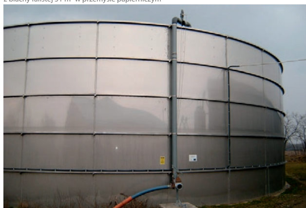
Откачивающая и заполняющая станция с трубой над стенкой резервуара System opróżniania i napełniania nad ścianą zbiornika
