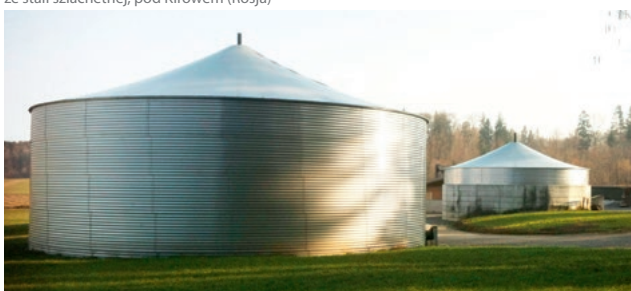
Резервуар из волнистой стали и бетонный резервуар с надстроенным резервуаром из волнистой стали | Zbiornik z blachy falistej oraz zbiornik betonowy z nadbudowanym zbiornikiem z blachy falistej
