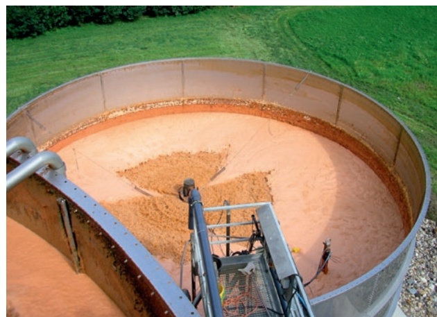
Резервуар для сточных вод Zbiornik ściekowy
