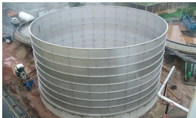
Резервуар для сточных вод 1661 м 3 в бумажном производстве Zbiornik ściekowy 1661 m 3 do przemysłu papierniczego
