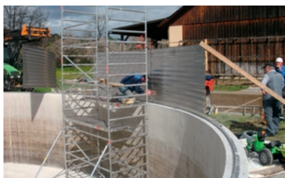
Надстройка резервуара Rozbudowa zbiornika w górę
