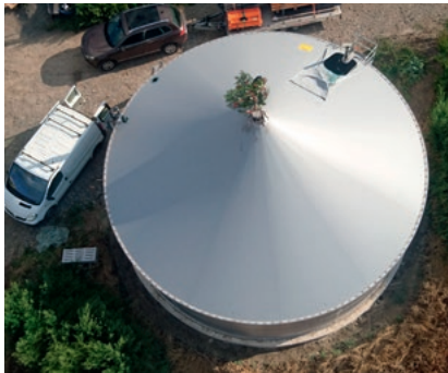
Мембранная крыша, вид сверху Dach namiotowy od góry
