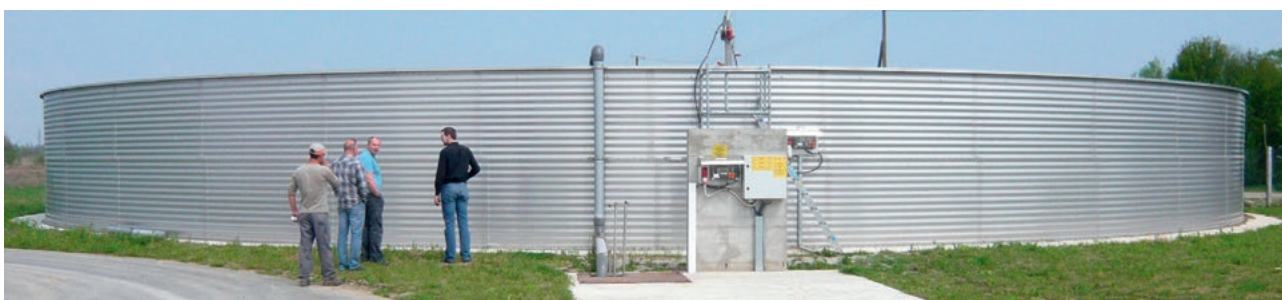
Резервуар из волнистой стали в Хорватии Zbiornik z blachy falistej w Chorwacji
