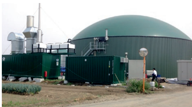
Биогазовый резервуар с двойной мембраной в Японии Zbiornik biogazu z dachem z membrany podwójnej, Japonia
