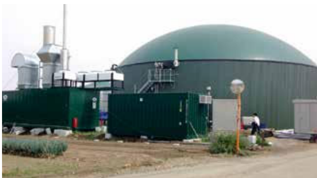
双层膜屋顶沼气发酵罐（日本） Biogas tank with double membrane roof in Japan
