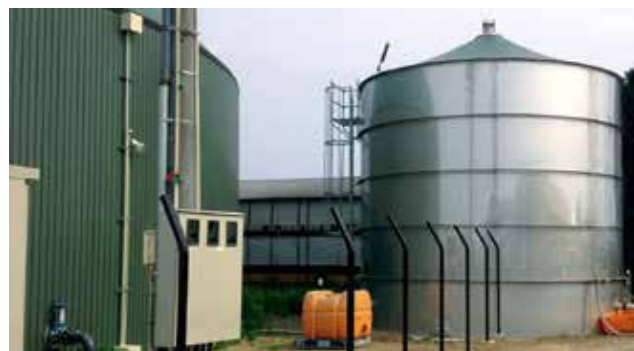
料斗和缓冲罐（日本） Hopper and buffer tank in Japan
