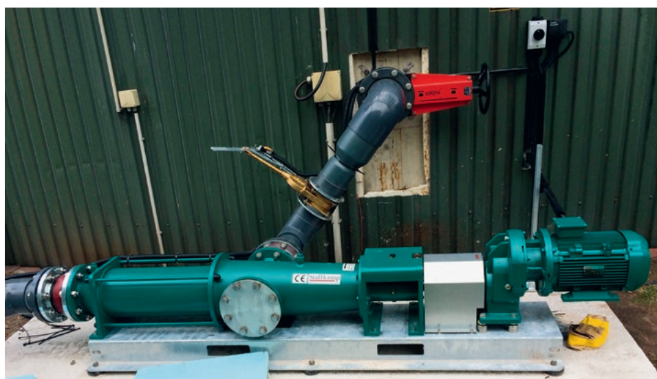
Pompe à vis excentrée horizontale en service dans une installation de biogaz Pompa a vite senza fine ad eccentrico orizzontale in un impianto biogas
