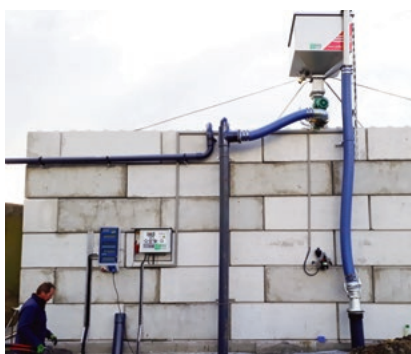
Sur cet élevage bovin, le séparateur est installé sur un mur en béton pour collecter les substances solides qui se trouvent en dessous.
