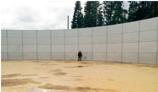
Le plus grand réservoir en acier inoxydable ondulé au monde près de Kirov (Russie), contenance : 8 559 m 3 | La più grande vasca in acciaio ondulato al mondo in acciaio inox di 8.559 m 3 vicino a Kirov (Russia)
