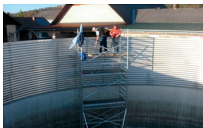
2 e couronne sur réservoir en béton 2° anello su contenitore di cemento
