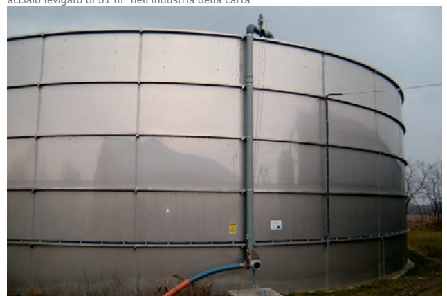
Station d'aspiration et de remplissage au-dessus du bord du réservoir Stazione di aspirazione e riempimento sopra il bordo del contenitore
