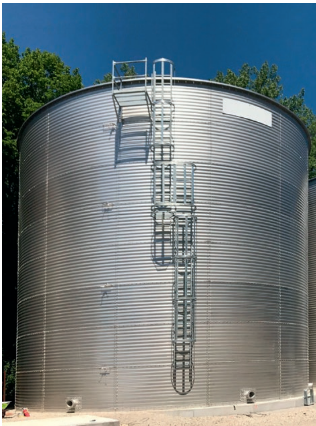
Réservoir de suspension de bentonite en Suisse, contenance : 1 304 m 3 Serbatoio di stoccaggio per sospensione di bentonite di 1.304 m 3 in Svizzera
