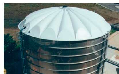
Conception de toit en dôme nervuré Esecuzione del tetto a cupola scanalata
