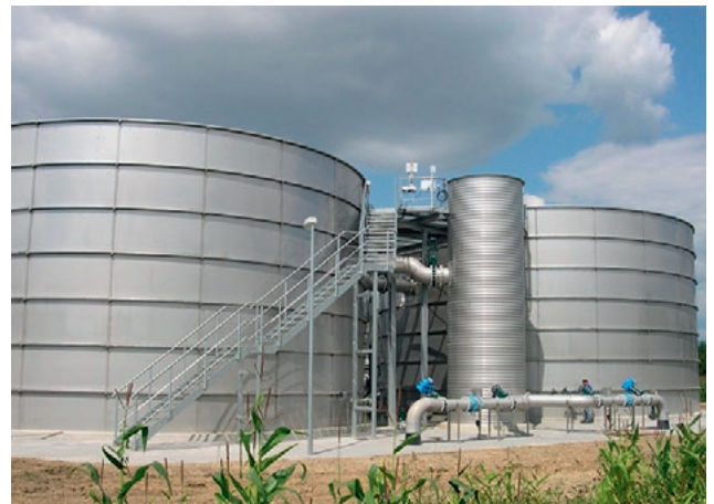
Réservoir en acier lisse de 1 664 m 3 et réservoir en acier ondulé de 51 m 3 dans l'industrie papetière | Contenitore in acciaio levigato di 1.664 m 3 e contenitore in acciaio levigato di 51 m 3 nell'industria della carta
