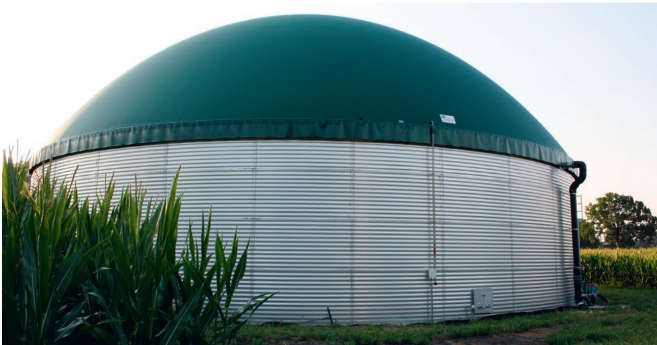
Réservoir de biogaz en acier inoxydable 1.4571 avec toit à double membrane étanche au gaz Fermentatore in acciaio 1.4571 con tetto a doppia membrana a tenuta di gas
