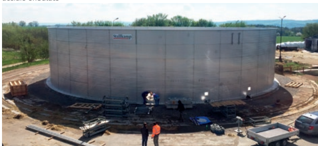
Réservoir en acier ondulé de 6 283 m 3 en République tchèque Contenitore in acciaio ondulato di 6.283 m 3 in Repubblica Ceca
