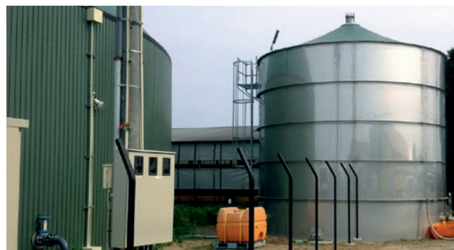
Réservoir collecteur et tampon au Japon Contentitore polmone e tampone in Giappone
