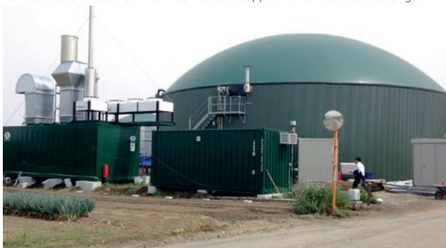
Réservoir de biogaz avec toit à double membrane au Japon Fermentatore con tetto a doppia membrana in Giappone
