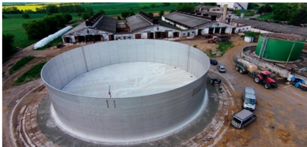
Réservoir en acier inoxydable vu d'en haut Vista dall'alto di un contenitore in acciaio inox
