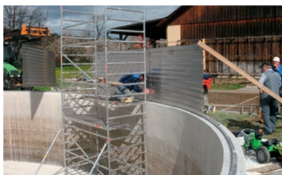
Surélévation d'un réservoir Estensione in altezza di un contenitore
