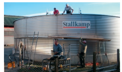
Réservoir en béton surélevé Contenitore di cemento esteso in altezza
